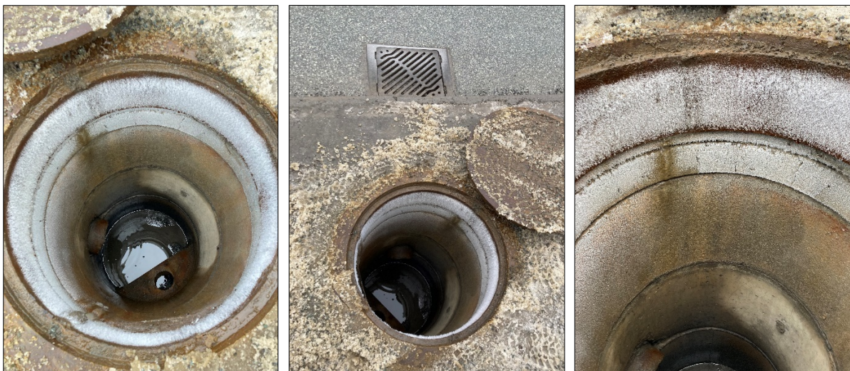
Figur 13 Sandfang med hjelpesluk. Bilder fra befaring Asplan Viak.
